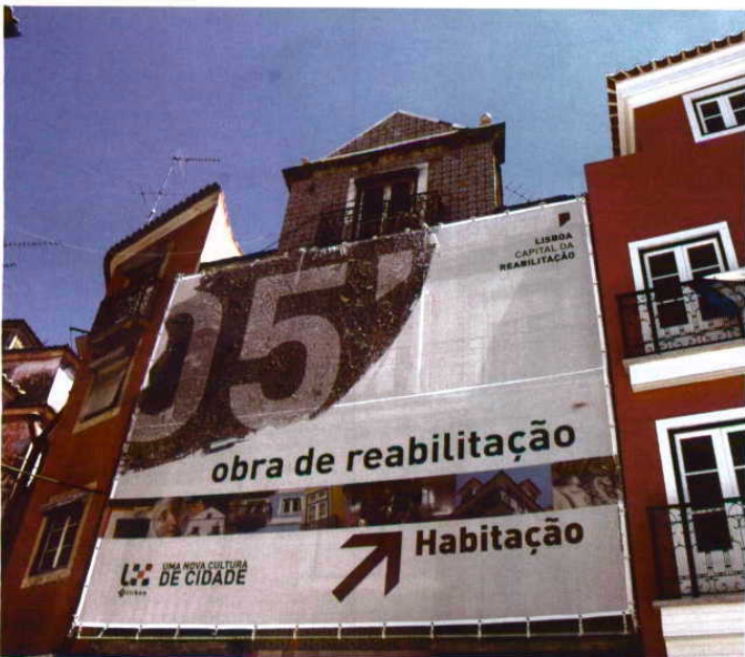
Centros históricos alvo de intervenções destinadas a torná-los protótipos da vida urbana
